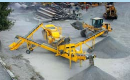
Дробильная установка RM80 в совместной работе с двухуровневым виброгрохотом CS3600/2 и конвейером возврата негабаритной фракции
